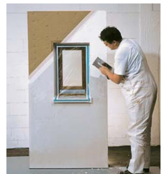
4. Celoplošné nanesení vrchní omítky a její strukturování (škrábaná struktura)
