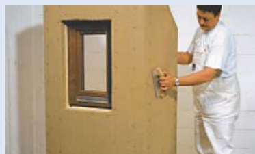
5. Obroušení přesahu tloušťky na spojích, příp. opracování spár na spojích desek
