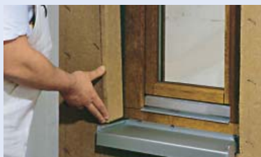
7. Montáž okenní špalety z desky INTHERMO HFD načisto
