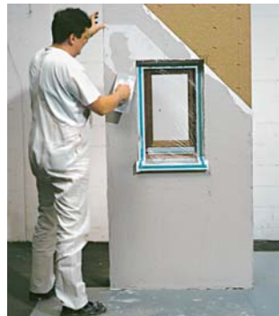
1. Provedení diagonálního armování INTHERMO HFD
