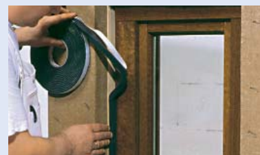
6. Přilepení pásky pro utěsnění spár na rám okna
