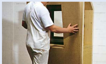
2. Nasunutí a přesné umístění desky do soklové lišty INTHERMO HFD
