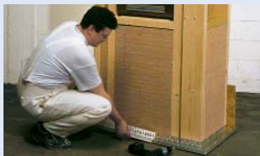
1. Montáž soklové lišty INTHERMO HFD
