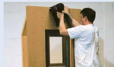
3. Upevnění desky pomocí širokých spon z ušlechtilé oceli (Haubold)
