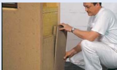
4. Pevné spojení drážka/pero
